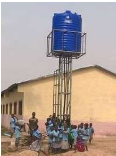
Exemple de puits avec pompe de relèvement et château d'eau financé par Appel Détresse
