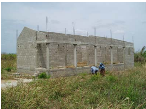
État d'avancement d'un des deux dortoirs
