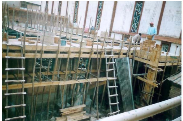
Travaux de rehausse du CNAD
