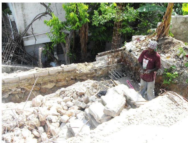
Déblayage du sous sol à terminer
