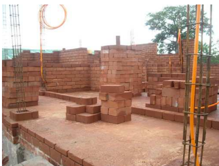
Le dortoir en construction
